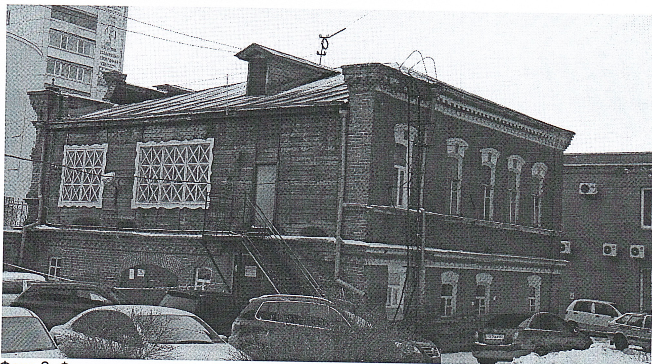
Фото 2. Фасады со стороны двора. Вид с северо-востока.
