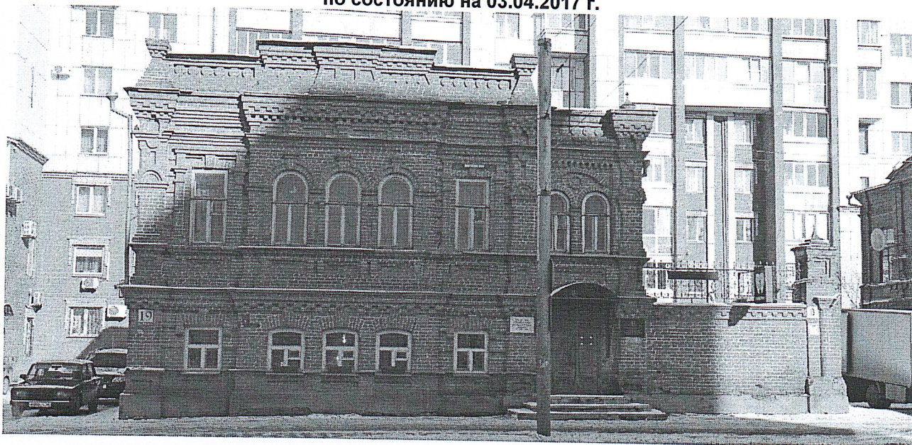
Фото 1. Главный фасад, вид со стороны улицы Гоголя.
